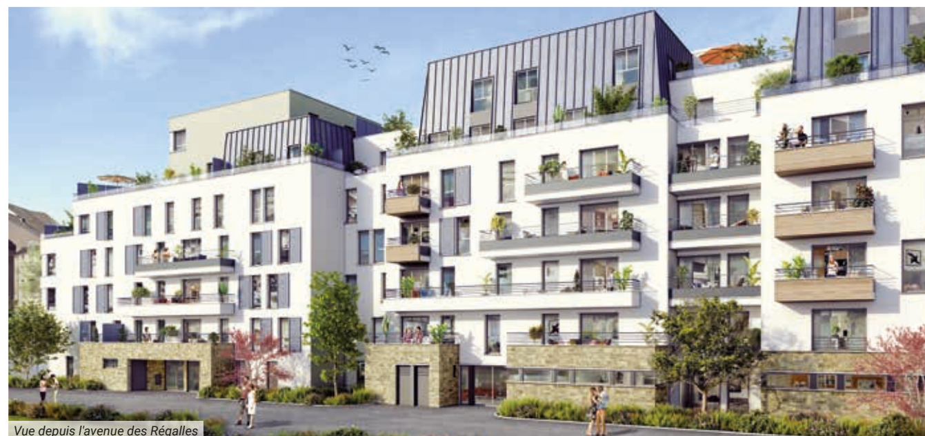
Vue depuis l'avenue des Régalles
